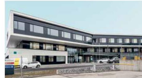
GESUNDHEITZENTRUM VÖCKLABRUCK_ NEUBAU 2018
